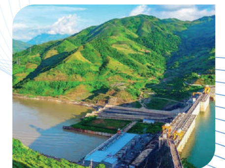
NHÀ MÁY THỦY ĐIỆN SƠN LA
